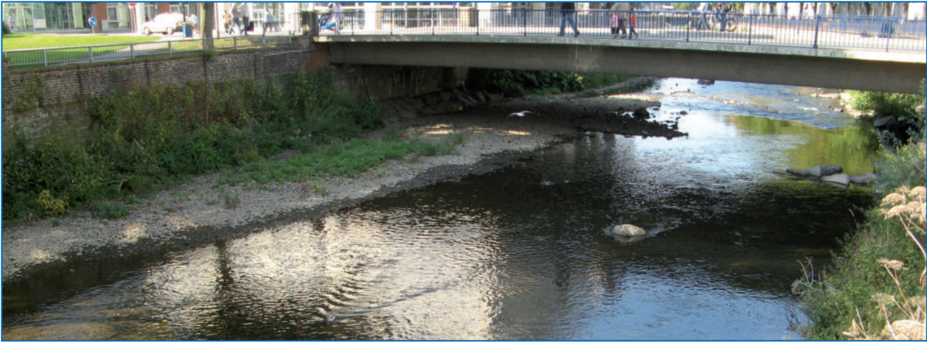
Abb. 3: Mitten in der Hagener City kann man an der Volmebrücke der Rathausstrasse die Wasseramsel bei der Nahrungssuche beobachten. Im Zuge der Volmerenaturierung in der Zeit um 2005 wurden in einem Abschnitt der City betonerte Wehre und die Betonsohle entfernt. Die in das Flussbett eingebrachten Störsteine eignen sich als Sitzwarte. Durch diese Maßnahmen haben sich offensichtlich die Wasserinsekten- und Fischfauna und damit auch die Lebens- und Nahrungsbedingungen der Art erheblich verbessert. 28.9.2008. Foto S. SALLERMANN
