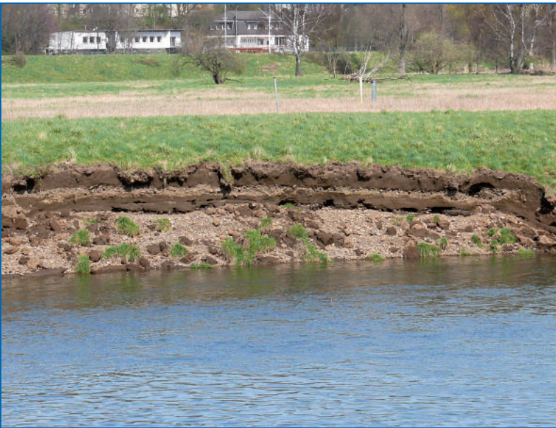
Abb. 2: Natürlicher Brutplatz in einer Uferabbruchkante der Ruhr westlich des Wasserwerkes von Wetter dicht an der Hagener Stadtgrenze gelegen. Seit dem Jahrtausendwechsel brüten hier Uferschwalben, in der ersten Zeit noch mit ca 25-30 Brutpaaren. 2008 waren nur noch einzelne Brutröhren besetzt. Foto M. WÜNSCH
